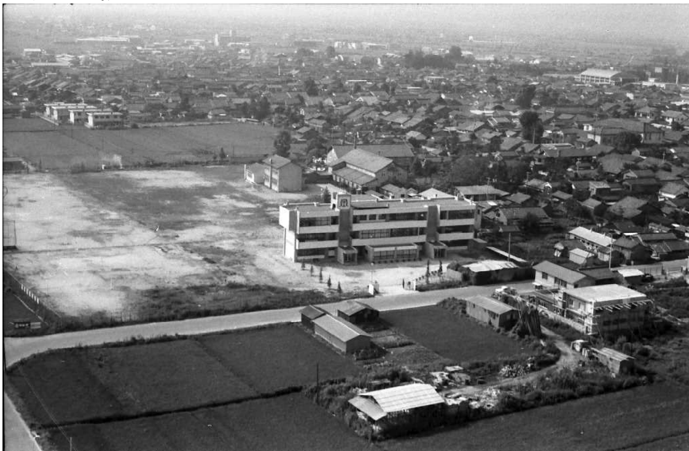
北側からの撮影：旧本館が竣工直後ではないかと思われます
